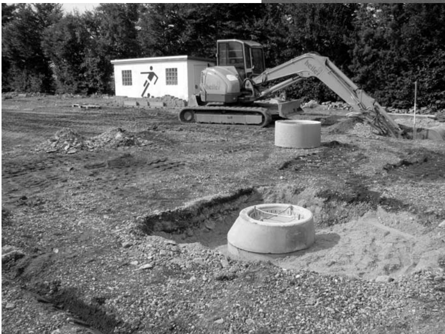
Einbau Drainage
